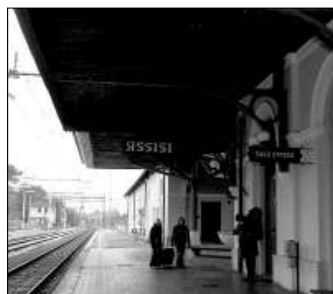
La stazione di Assisi
