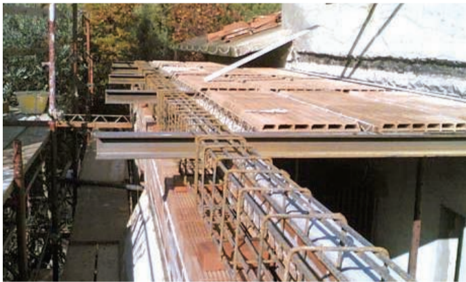
Un intervento di ristrutturazione
