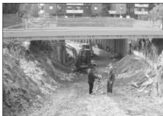
I lavori del sottopasso
