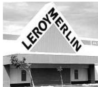
A settembre, ad Ospedalicchio, inizieranno i lavori per l'apertura del punto vendita Leroy Merlin
