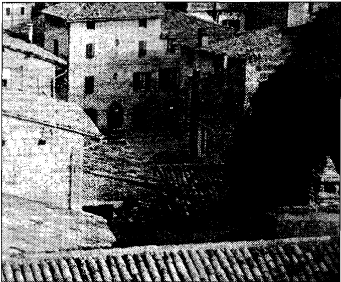
Cannara Polemiche sulla provinciale che la collega
