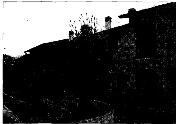
Problemi La copertura del tetto non sarebbe impermeabile
