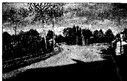
Lavori Nuova viabilità nella zona
