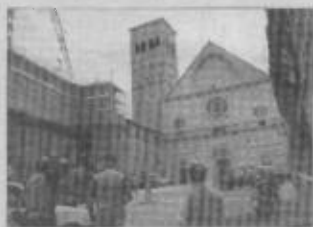
San Rufino Lavori per la fonte
