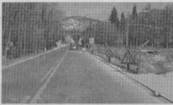
Assisi Una foto d'archivio del cantiere della Mattonata
