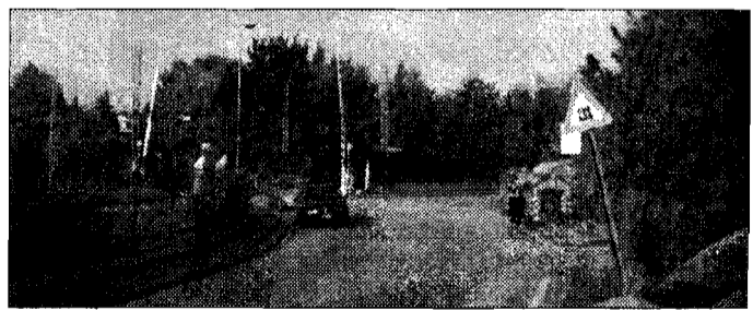
Oggetto di discordia Il sottopasso di San Rocco
