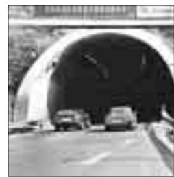
Galleria sulla E 45
