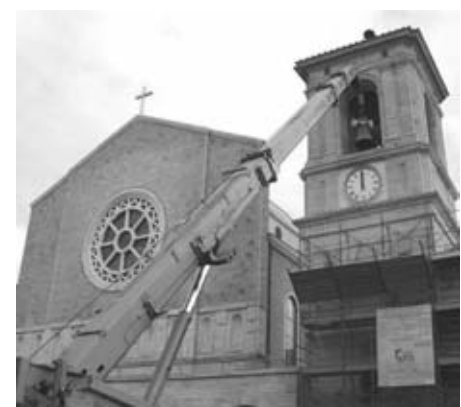
LAVORI Nella foto di Francesco Fratellini, la sistemazione delle campane
