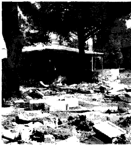
Ex piscina Eden Rock Dopo la demolizione
