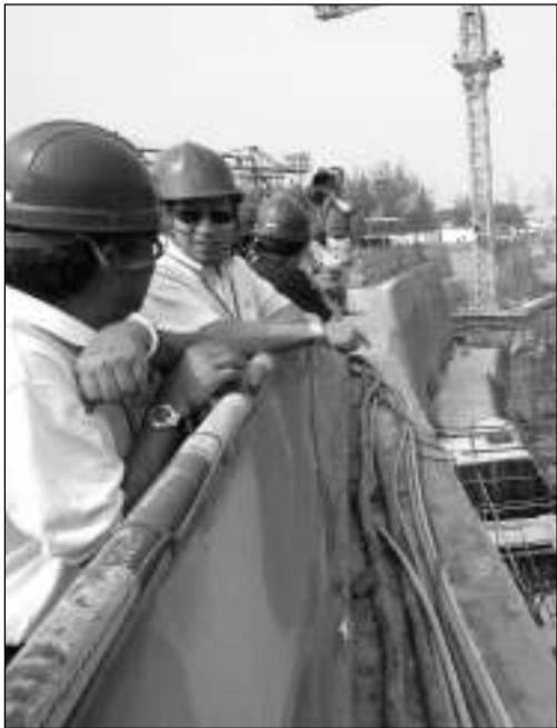
Operai in un cantiere edile
