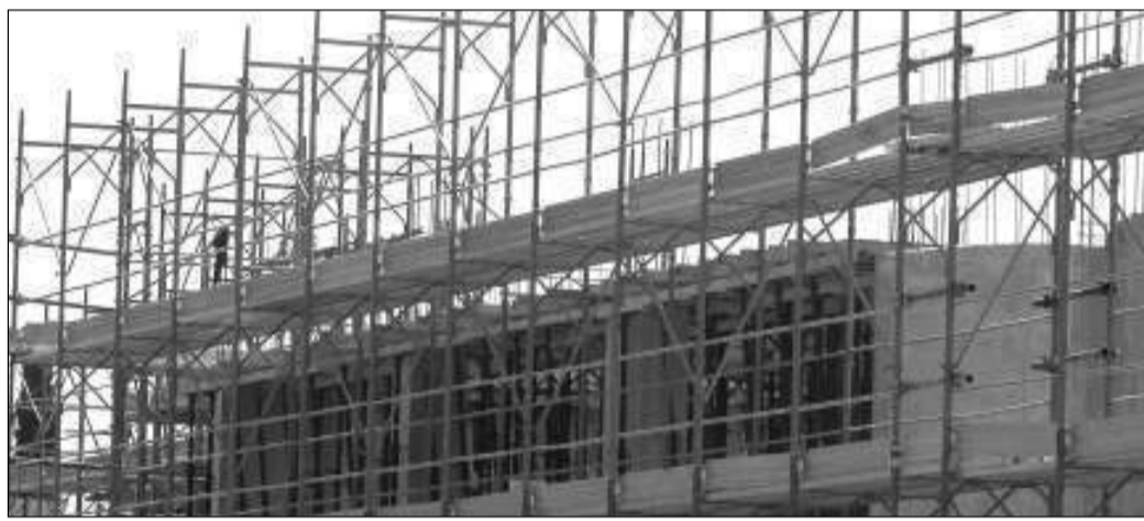
Un cantiere edile
