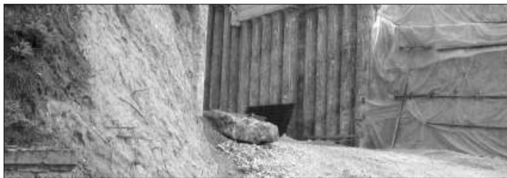
I lavori per il parcheggio di Mojano
