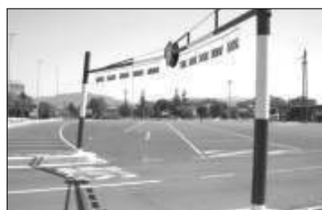
Le sbarre danneggiate
