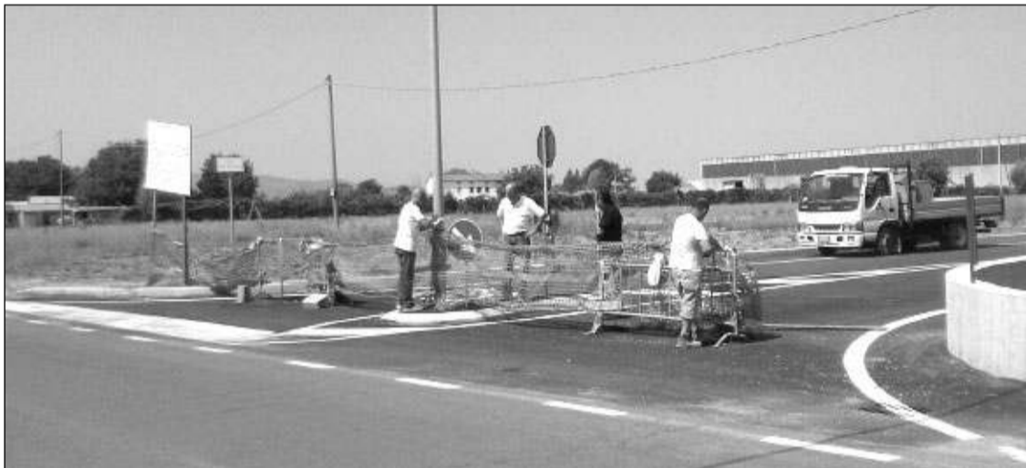
La nuova strada della zona industriale di Santa Maria degli Angeli
