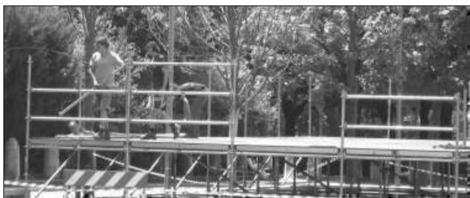
Gli operai al lavoro per montare il palco dal quale parlerà Benedetto XVI
