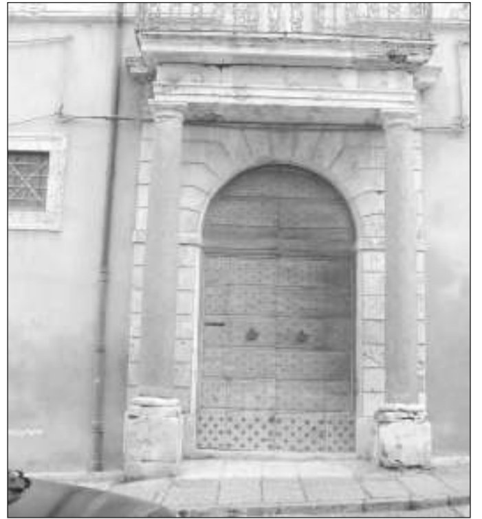
L'ingresso di palazzo Vallemani
