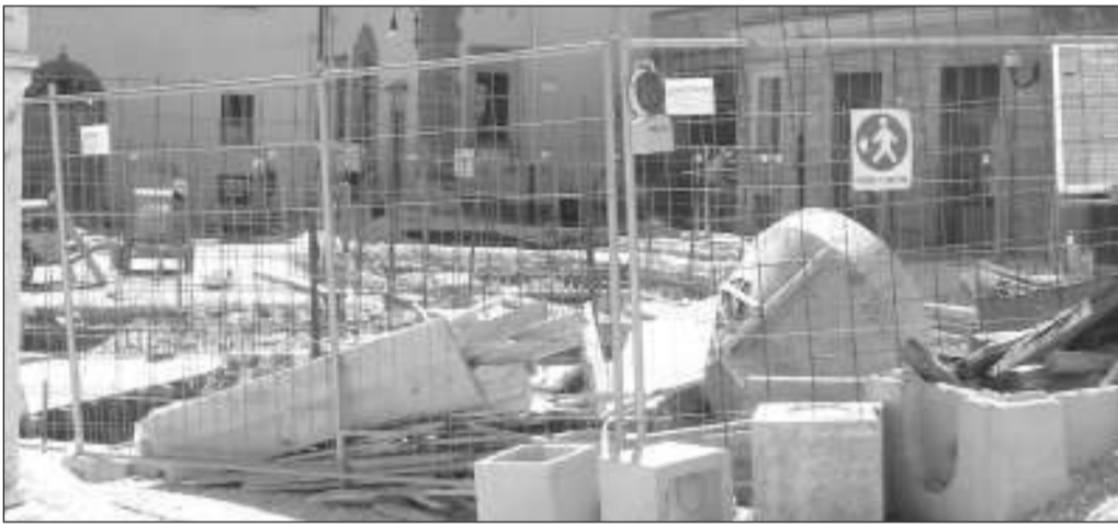
I lavori in piazza Cavour a Bettona
