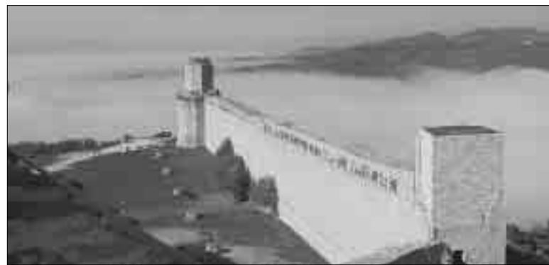
La Rocca Maggiore di Assisi è stata edificata a metà del 1300
