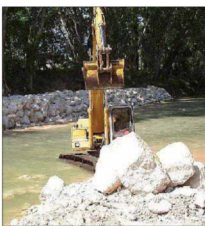
Intervento Sul fiume Topino
