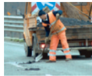
LAVORI IN CORSO Indispensabili nel territorio
