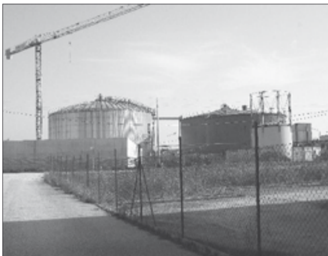
Depuratore Al centro dell'inchiesta della magistratura
