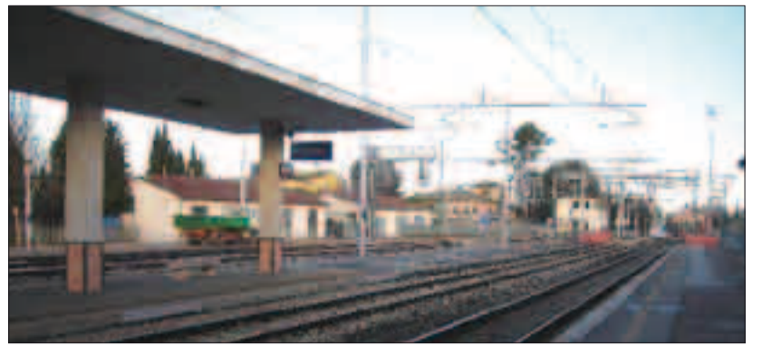
Niente più stop Inaugurazione per il sottopasso ferroviario
